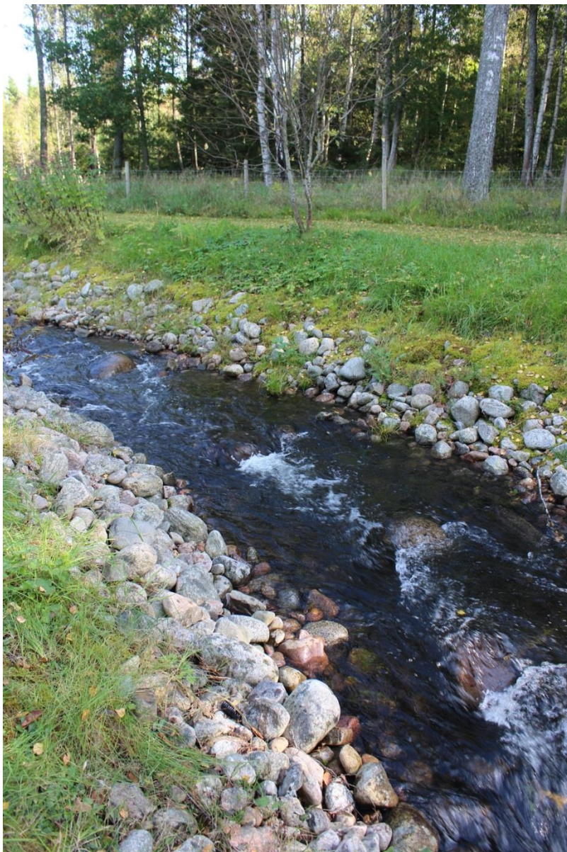
Figur 36. Omlöpet höll ett bra flöde. De sista 10 metrarna av omlöpet har en ganska brant lutning. Foto: Carl-Johan Månsson
