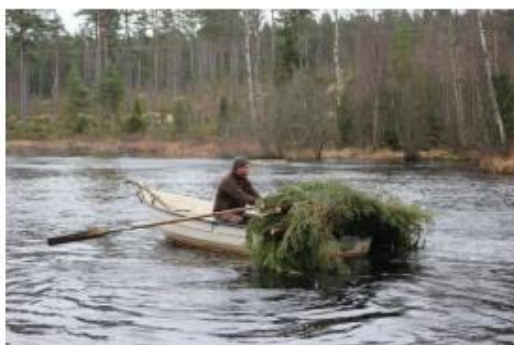
Figur 5. Vase modell "nät och ris". Riset packas in i ett fjärnät eller med stålband och så tippas hela paketet i vattnet på 1-2 m djup. Störrar slås ned i botten som förankrar paketet och märker ut det. Foto: Carl-Johan Månsson
