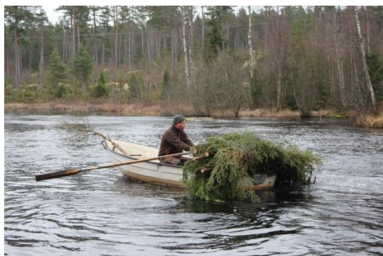
Figur 82. Vase modell ”nät och ris”. Från Alsterån och Uvasjöns FVO. Riset packas in i ett farnät eller med stålband och så tippas hela paketet i vattnet på 1-2 m djup. Störar slås ned i botten som förankrar paketet och märker ut det. Foto: Carl-Johan Månsson
